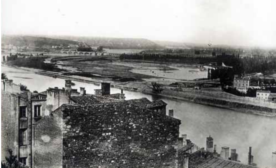
Cantiere del parco de la tête d'or, veduta presa dalla riva destra del Rodano, fotografia in bianco e nero, anonimo, 1858, Inv. N 549.17
