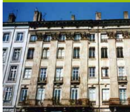
Façade du 3 quai Lassagne anciennement quai Saint-Clair dit "Soufflot" avec ses colonnes corinthiennes surmontées d'œils-de-bœuf, Archives municipales.
